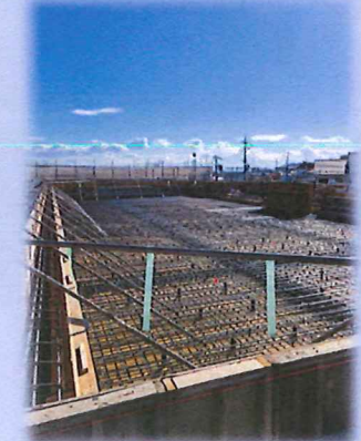
【11月下旬：R階梁スラブ配筋完了】
