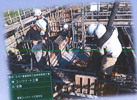
【基礎コンクリート打設作業】
