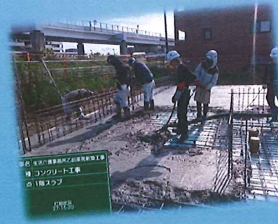
【1F スラブコンクリート打設作業】
