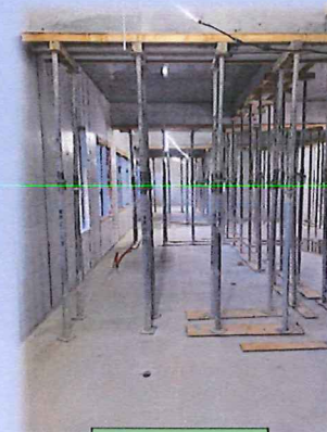
【1F 梁養生中】
