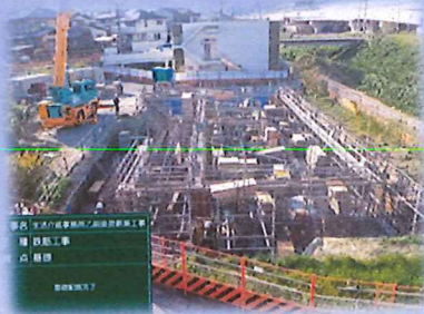
【9月上旬：基礎配筋完了】
